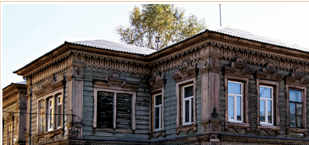
Иркутская деревянная архитектура
