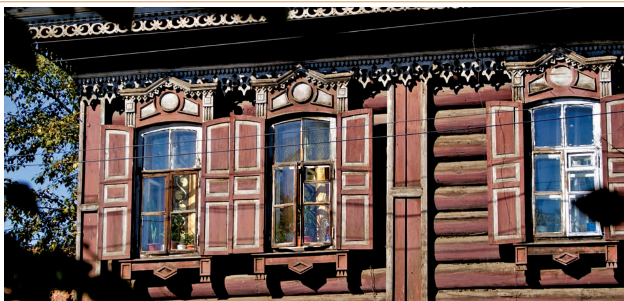
Иркутская деревянная архитектура
